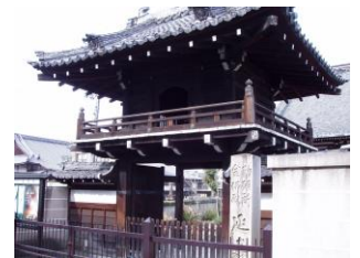
鐘楼門 延壽院 (京都市)
