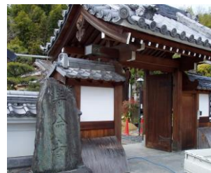
京田辺市 寿命寺 薬医門
